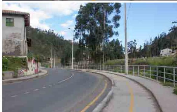
Ciclovía segregada en toda la longitud del trazado, presenta señalización horizontal y vertical para eje bidireccional. El estado de la calzada es bueno, sin embargo se observa la falta de limpieza de carriles, lo que impide que sea utilizada
