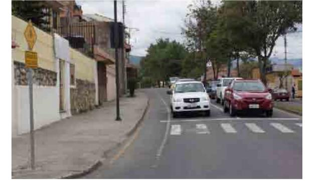
**Sección de circulación compartida, con pendiente máxima del 2%, posee capa de rodadura en material de mejoramiento compactado**
