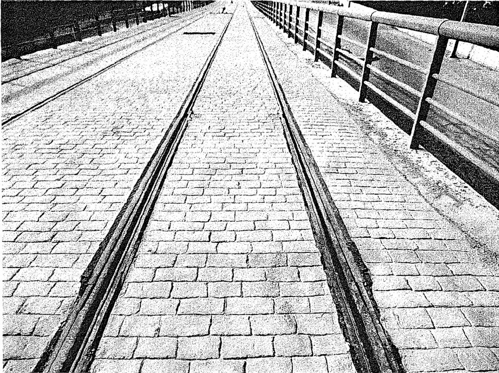
Ilustración – fotografía de un aparato de dilatación
