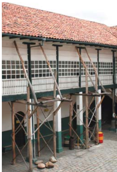
Fotografía 15. Apuntalamiento del edificio debido a problemas estructurales, 2005.
