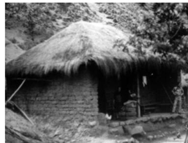
Ilustración 78: Casa cubierta de paja con paredes de adobe. Fuente: Muñoz, *Arquitectura...*, 79.
