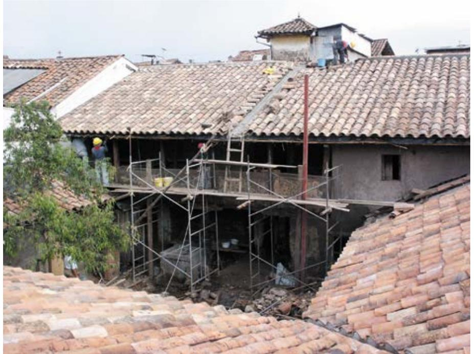
Ilustración 103: Colocación de cruz en la cumba luego de arreglos en la cubierta.
