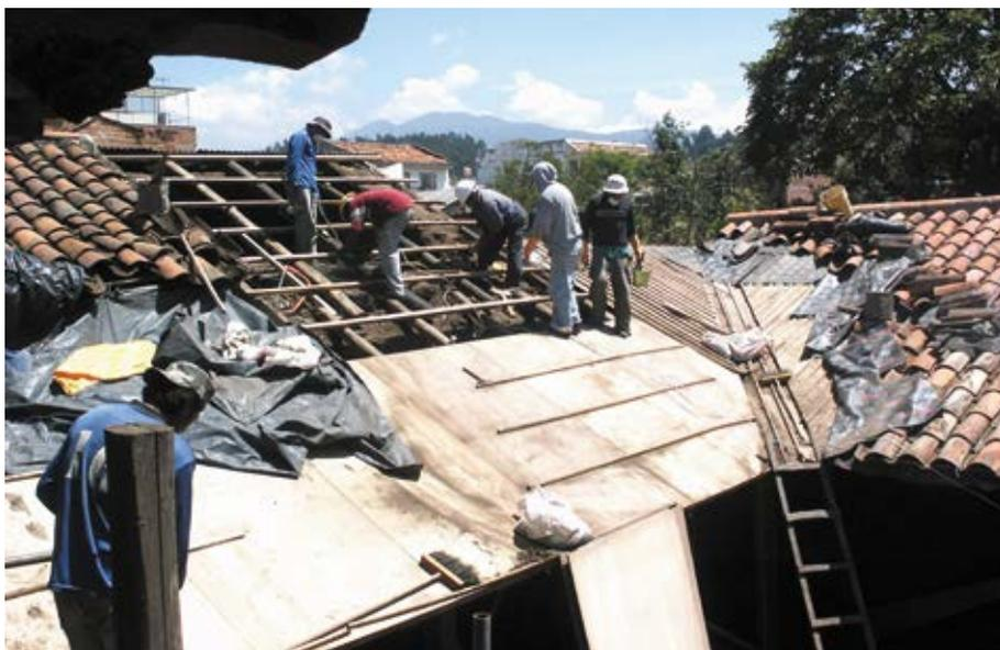
Ilustración 63: Faldón sobre el corredor oeste del patio principal de la Casa de las Posadas, este elemento de la cubierta es compartido con la edificación vecina. Fuente: Equipo consultor, 2005.
