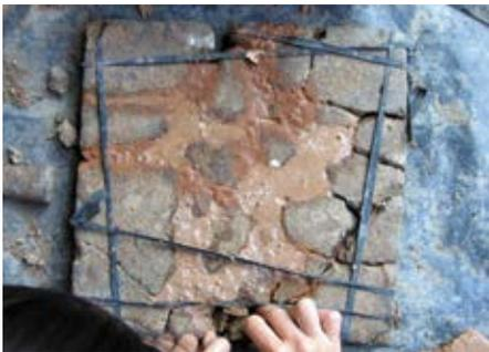
Ilustraciones 130 y 131: Colocación de malla metálica previa fundición de capa de hormigón y vigas metálicas ubicadas en la tienda este para soportar la estructura original del entepiso de la crujía frontal.
