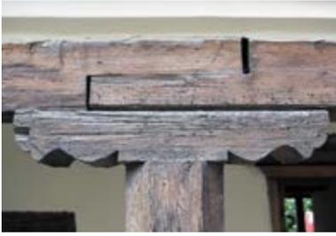
Ilustración 75: Detalle de unión entre solera de alero y columna.
