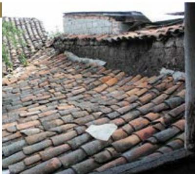
Ilustraciones 95 y 96: Faltante de cubierta original en faldón y pilar abombado en fachada posterior de crujía frontal.
