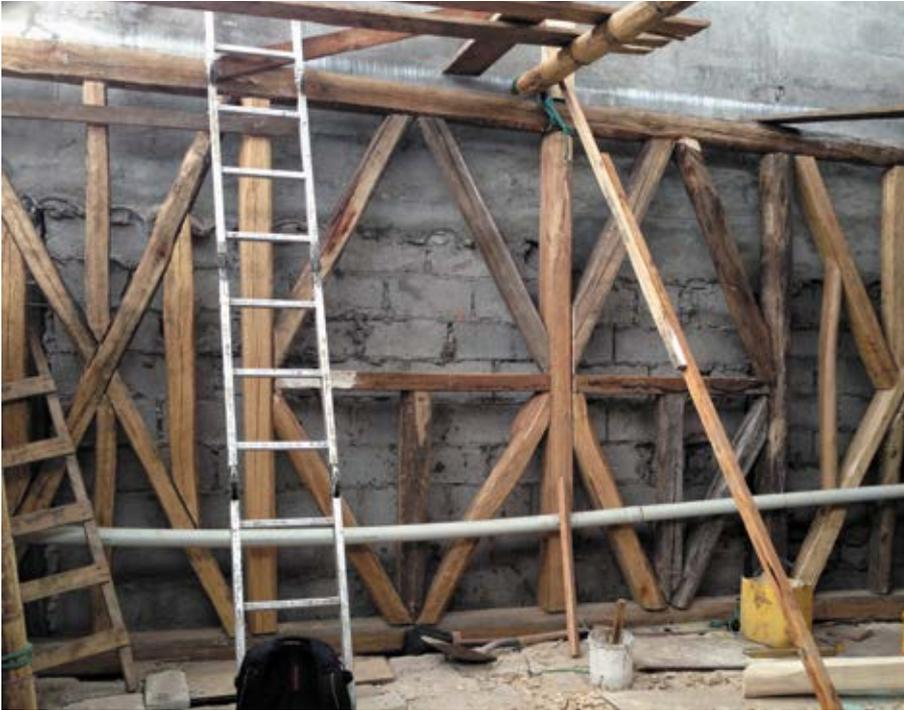
Ilustración 202: Estructura de madera para conformar muro de bahareque norte en planta alta.
