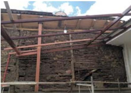
Ilustraciones 195 y 196: Colocación de ladrillos sobre cantoneras originales en piso superior de crujía frontal y refuerzo de carrizos en muro de bahareque durante la intervención.
