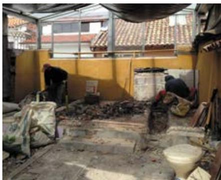
Ilustración 191: Cubierta provisional sobre crujía frontal durante la intervención.
