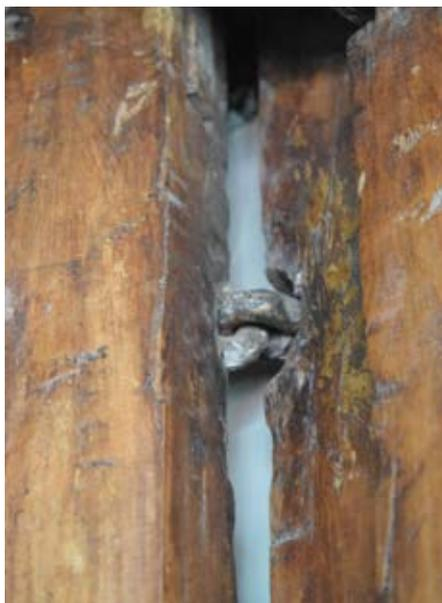
Ilustraciones 117 y 118: Bitoque y molduras en puerta de habitación oeste posterior de planta alta y goznes en puerta de habitación principal de la crujía frontal.
