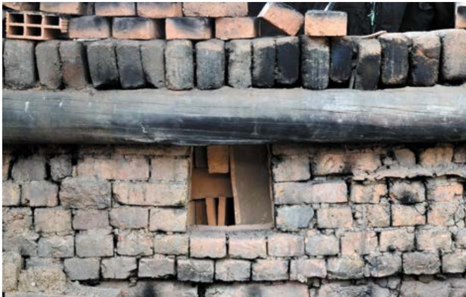
Ilustración 154: Horno para la cocción de ladrillos.
