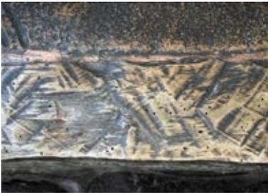
Ilustración 76: Detalle de las *heridas* dejadas por la herramienta sobre el madero en la huella de las gradas de acceso al nivel superior.
