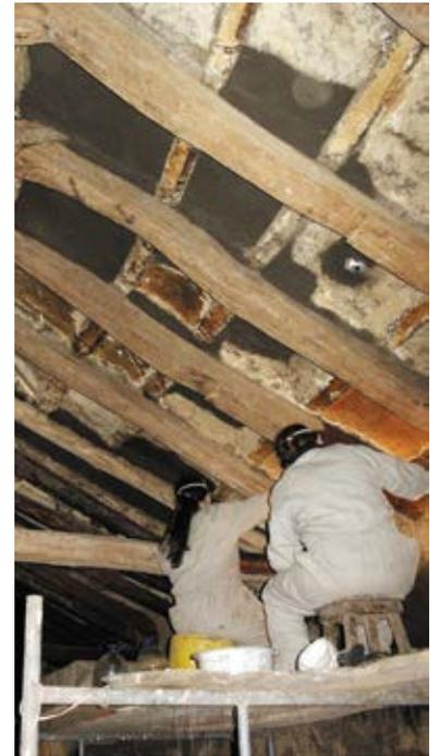
Ilustraciones 105 y 106: Detalle de anclajes que sujetan los pares originales al refuerzo metálico en la cubierta de la crujía principal y arreglo del cielorraso desde el interior.
