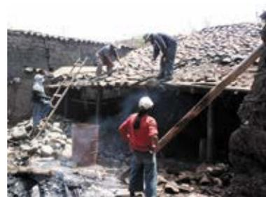
Ilustración 109: Desarmado de la cubierta sobre la crujía este del segundo patio.
