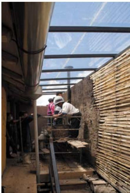
Ilustraciones 222 y 223: Los participantes del taller de revoques de tierra ejecutan muestras decorativas sobre ladrillos y en la imagen siguiente colocan mortero de barro sobre un tejido mixto de carrizo y caña guadua.
