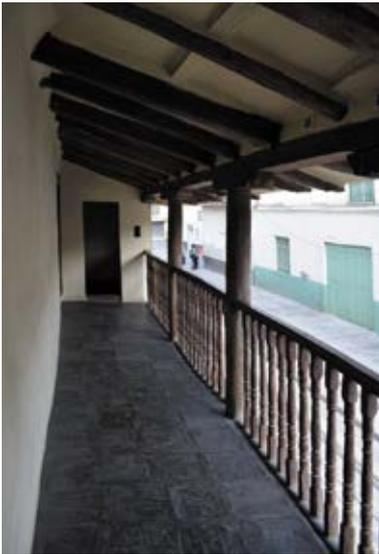
Ilustración 47: Corredor del segundo nivel con piso enladrillado.
