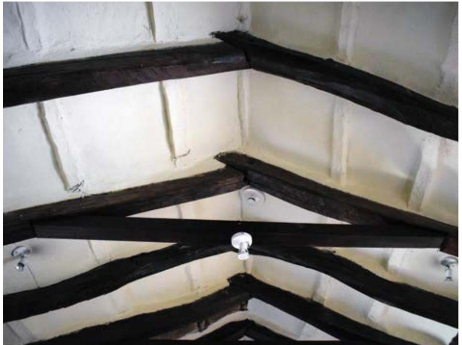
Ilustración 104: Cielorraso y estructura de cubierta en la habitación superior de la crujía frontal luego de la intervención.
