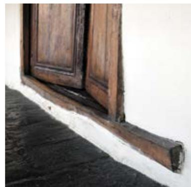
Ilustración 74: Umbral de la puerta de acceso a la habitación central superior de la crujía frontal luego de la intervención.
