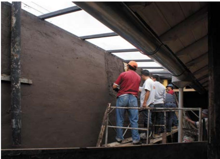
Ilustración 224: Los asistentes revocan el muro norte posterior de la planta alta durante el taller.
