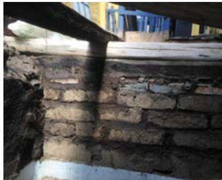
Ilustraciones 203 y 204: Calzaduras en muros de adobe en planta baja.
