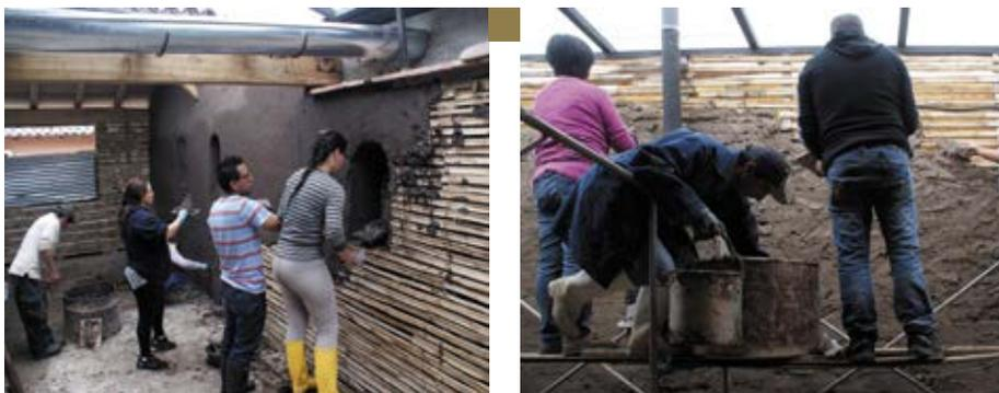
Ilustración 225: Los participantes revocan el muro norte de la crujía frontal en planta alta.
