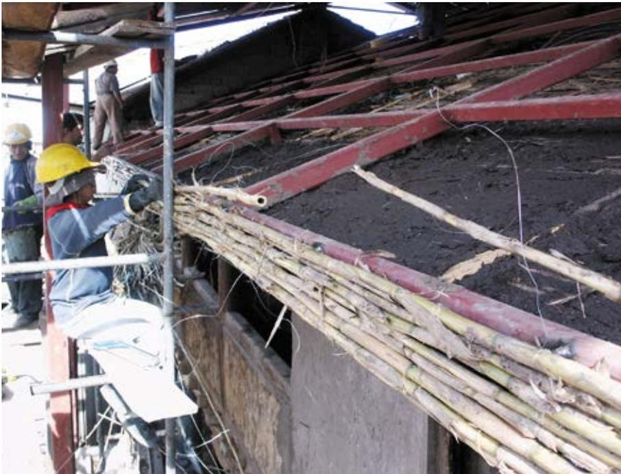
Ilustraciones 107: Reposición de mortero de barro sobre cama de carrizo en crujía frontal.
