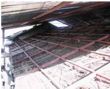
Ilustración 99: Cielorraso y estructura de cubierta en la habitación alta de la crujía frontal.
