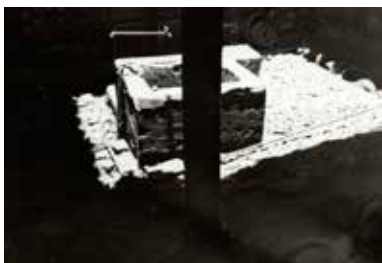
Ilustración 23: “Detalle de patio interior. Sector noroeste”. Otra de las mejoras dentro de las tiendas era el lavador de ropa, en general solía construirse en el patio. Fuente: Ávila et al., “Barrio...”, 27.
