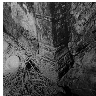
Ilustración 18: Basa labrada de piedra y pilar sunchado. Fuente: DGAHP. Inventario de patrimonio inmueble, 1975.
