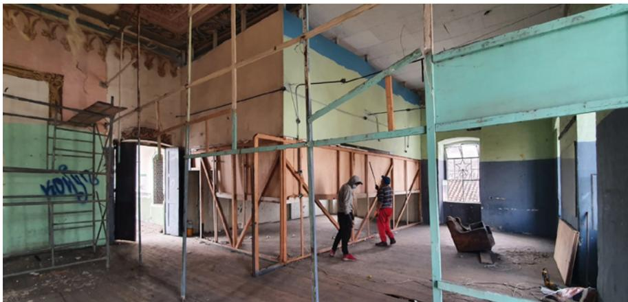
Ilustración 52: Seguimiento de los retiros en el salón principal, bloque A; liberación de tabiquerías.
