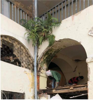
Ilustración 36: Análisis patológico, lesiones bioquímicas: vegetación parasitaria en muros.
