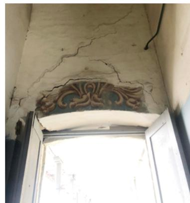
Ilustraciones 34 y 35: Análisis patológico; lesiones mecánicas: grietas en muros de adobe.
