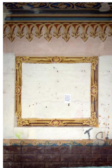
Ilustraciones 23 y 24: Detalle de zócalo que emula un conjunto de sillares rematados por una moldura rococó y marcos elaborados sobre el muro, los cuales encerraban pinturas al óleo y de tipo tabular.
