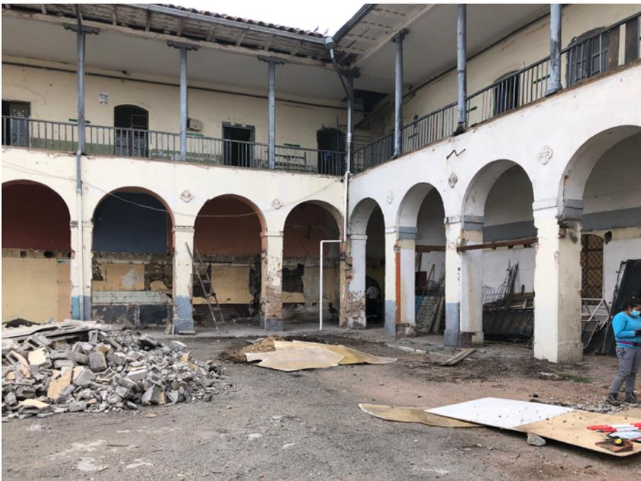
Ilustración 46: Liberación del portal en el nivel inferior de los bloques A y B.
