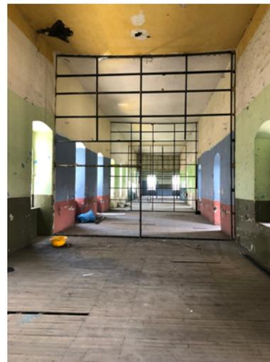
Ilustración 54: Liberación de tabiques de madera en nivel superior del bloque B.
