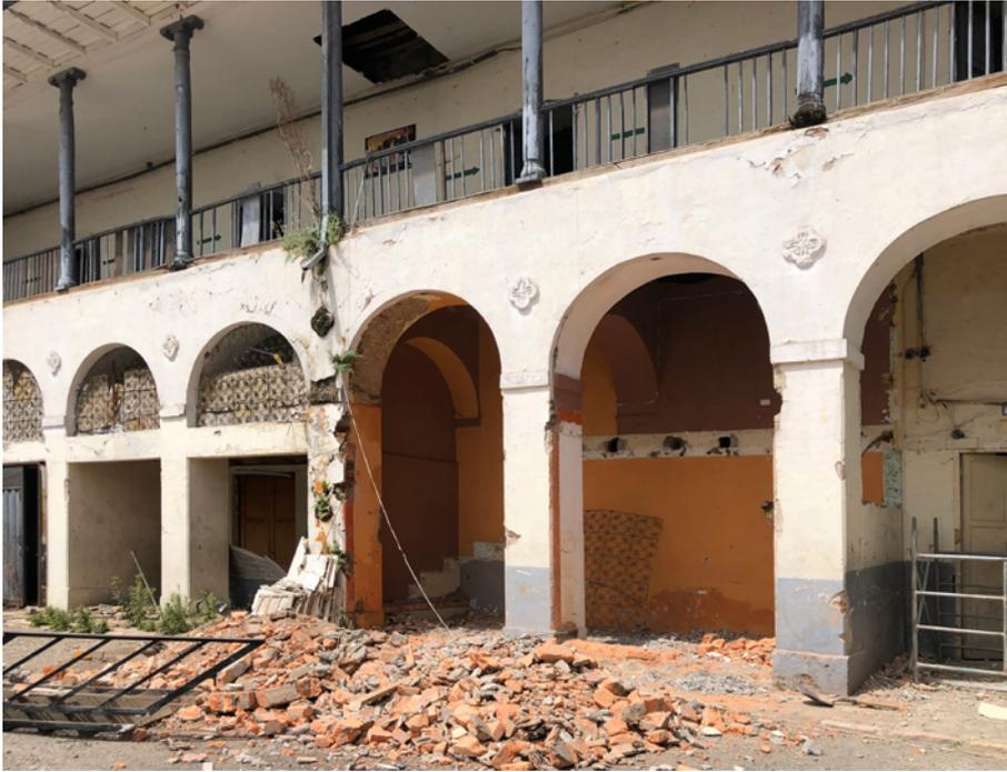
Ilustración 45: Liberación de elementos añadidos en el primer nivel del bloque B.
