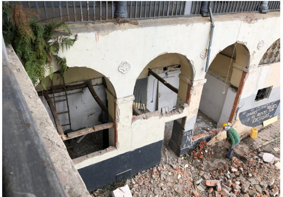
Ilustración 44: Obras de liberación en el portal del nivel inferior del bloque B.
