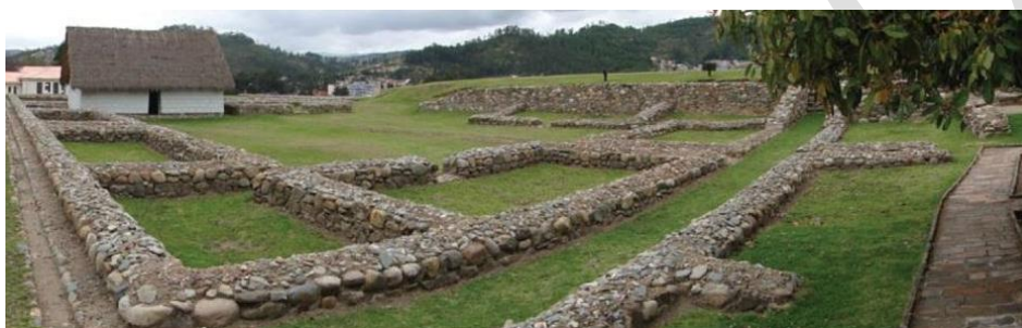
Fotografía3 Vista General del Complejo
