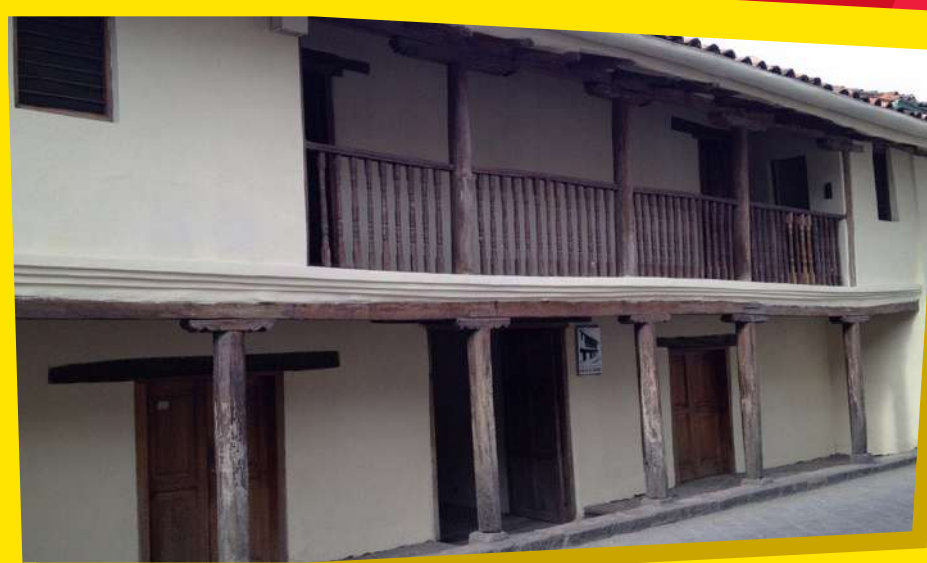
★ CASA DE LAS POSADAS Dirección: Calle Gran Colombia 17-42 y Octavio Cordero.
