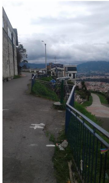
Ilustración 4 Área de trabajo para retiro de materiales
